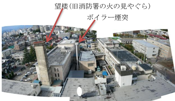
解体直前の旧庁舎
