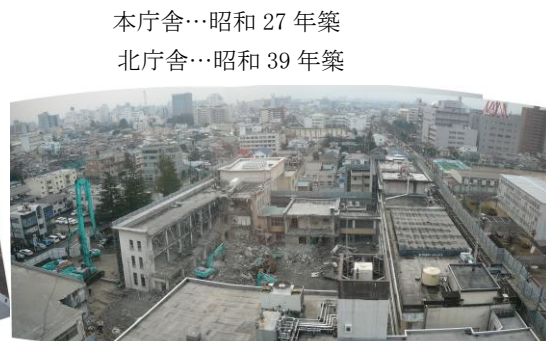
解体中(H23.3.8)の旧庁舎
