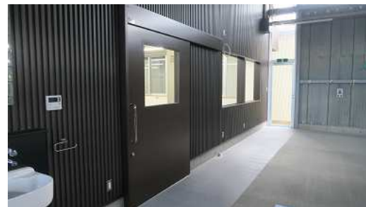
事務所と車庫の間に段差がない
