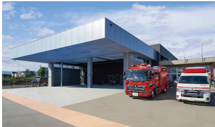
福島消防署清水分署新庁舎▶
