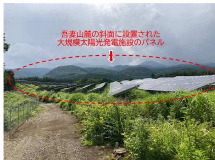
山地斜面に設置されたパネルの状況
