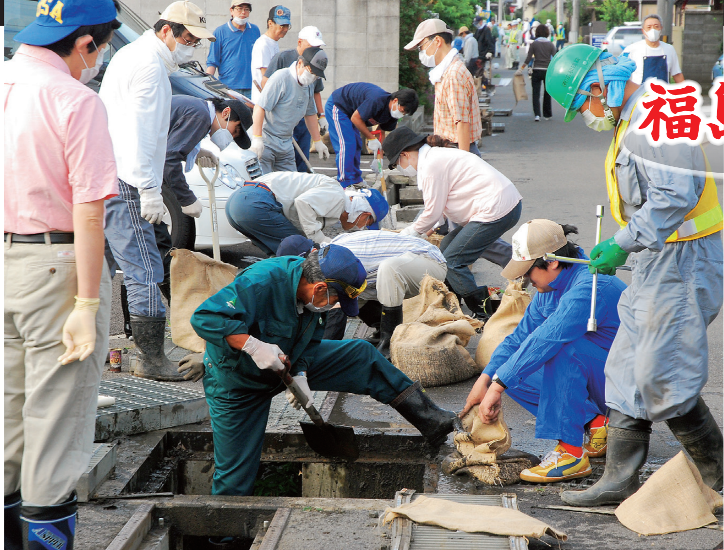
▶7月に行った渡利地区の除染。住民と市の協働により、側溝の土砂上げや通学路の洗浄、住宅の除染実験などを実施した
