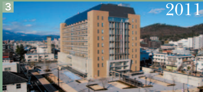
3 市役所新庁舎東棟開庁 免震構造を採用し、2カ月後に発生した東日本大震災時には防災拠点として機能。
