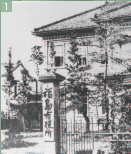
1 市制施行直後の福島市役所 庁舎は町役場そのままに、表札だけが新しく掛け替えられた（現在の福島第一小学校東隣り 昭和18年竣工）。
