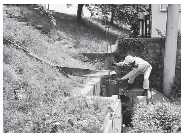
郷野目宝来1号樋門の排水ポンプ設置訓練の様子
