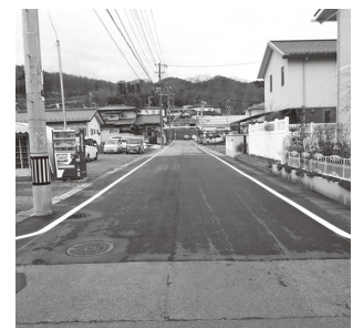
▲道路舗装の修繕
