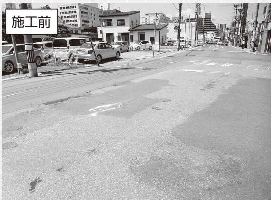
【道路白線補修の一例】
