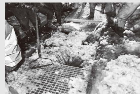
※復旧作業状況(R5.1.25深夜)
