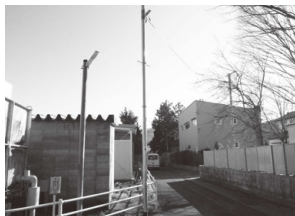
▲街路灯の設置
