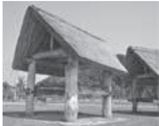
▲直径90cmの柱を使った掘立柱建物。1本の柱の重さは3トン以上
