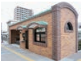
▲福島駅西口のレンタサイクル管理棟
