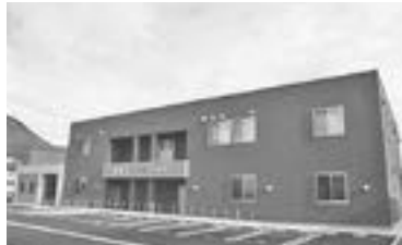
◀中核市への移行に向け、生涯を通じた健康づくり、保健衛生、健康危機管理の拠点となる保健所を整備しました (写真は保健所検査棟)
