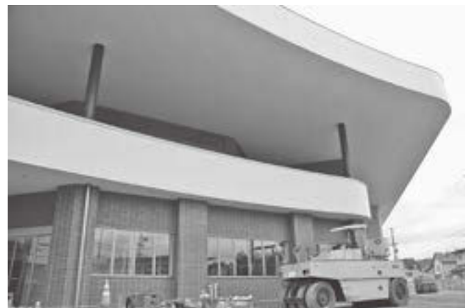
▲オープンに向けて工事が着々と進む福島市体育館・武道場
