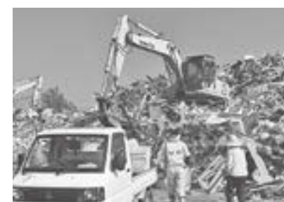
▲がれき搬入の作業現場(倉敷市)
