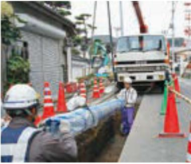
▲古くなった水道管を耐震性の高い水道管に入れ替える老朽管更新事業(市立図書館西側道路での工事)
