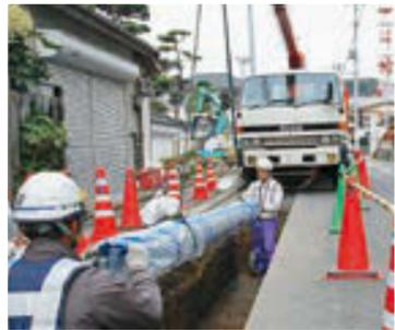
▲古くなった水道管を耐震性の高い水道管に入れ替える老朽管更新事業(市立図書館西側道路での工事)
