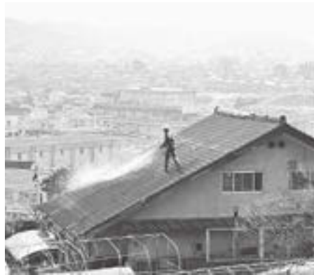
屋根の除染作業
