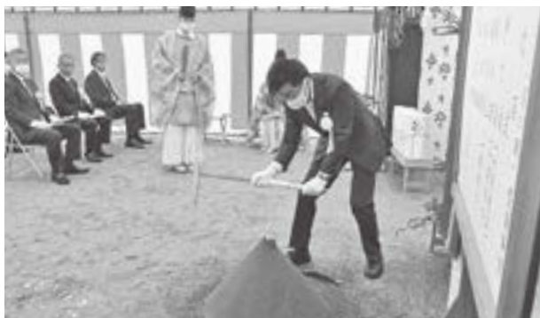
▲工事の安全成就を祈ってくわ入れ
