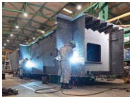
▲工場での橋桁製作。確かなものづくりで、社会インフラを支えています。
