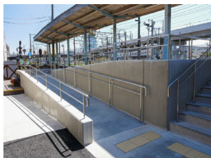
スロープの整備（曾根田駅）
