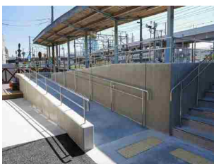
スロープの整備（曾根田駅）
