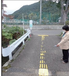
バス停からの誘導用ブロックが劣化している
