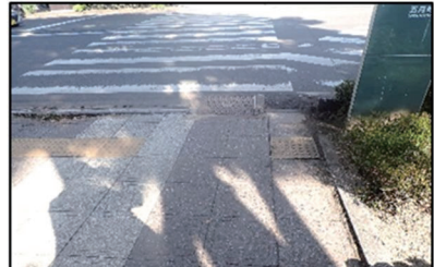
誘導用ブロックの連続性がない
