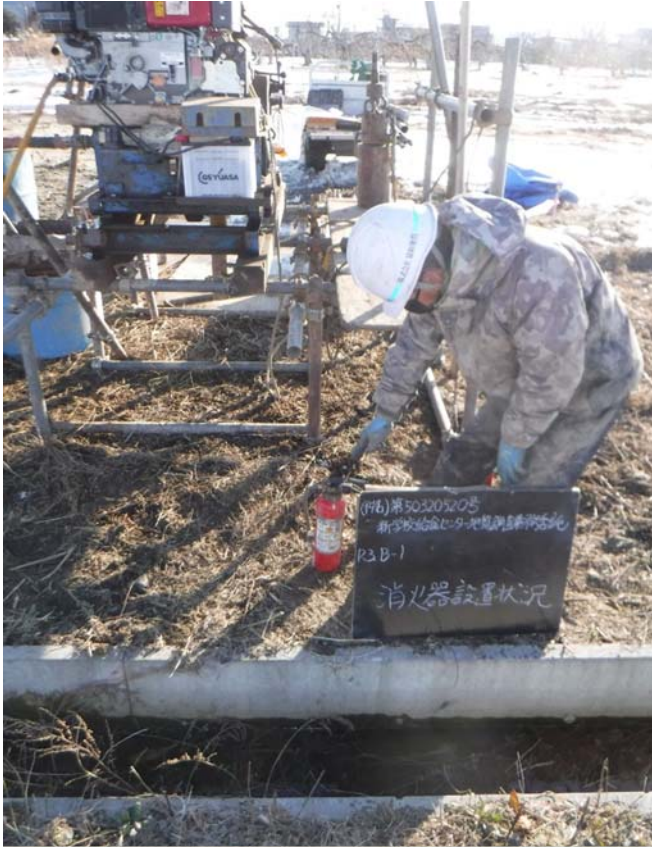
消 火 器 設 置 状 況
