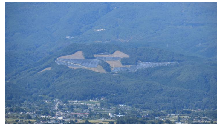
発電施設完成後の全景
