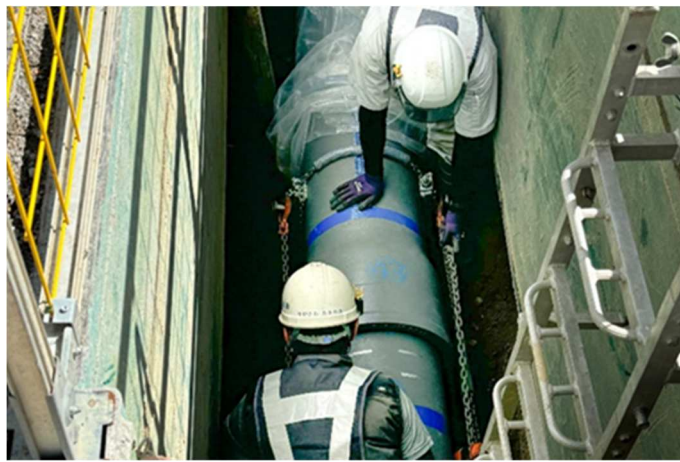
【基幹管路更新工事】
