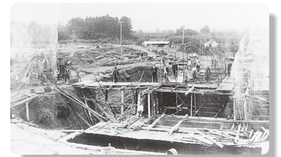
旧渡利浄水場の最初の工事
