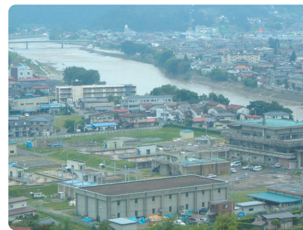
現在の旧渡利浄水場
