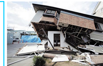
耐震シェルター
