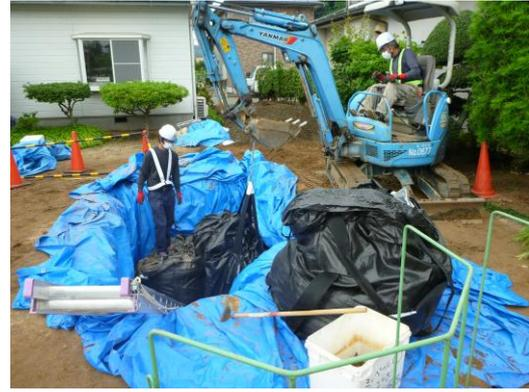
住宅の除染（現場保管）：地下埋設方式
