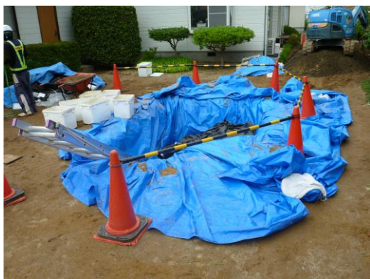
住宅の除染（現場保管）：地下埋設方式
