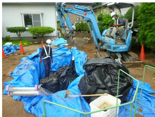
住宅の除染（現場保管）：地下埋設方式
