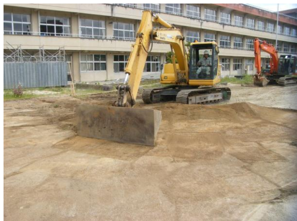
校庭の表土除去作業 (市内の小中学校、幼稚園９５施設で実施)
