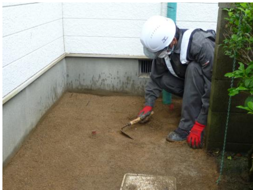
住宅の除染（庭土）：汚染状況を確認しながらの手作業による表土のはぎ取り作業
