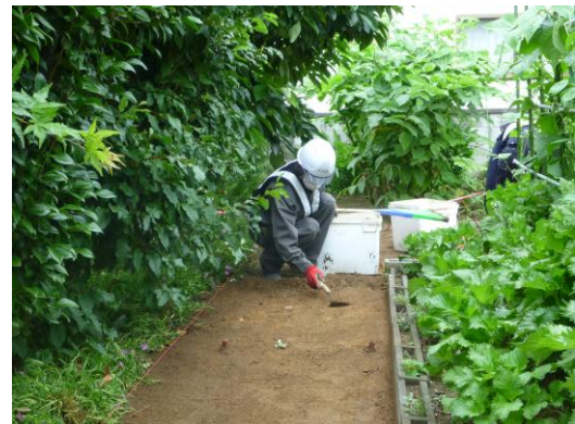
住宅の除染（庭土）：汚染状況を確認しながらの手作業による表土のはぎ取り作業
