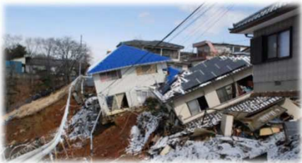
2011年3月11日 東日本大震災 市内での土砂崩れ・家屋倒壊の様子
