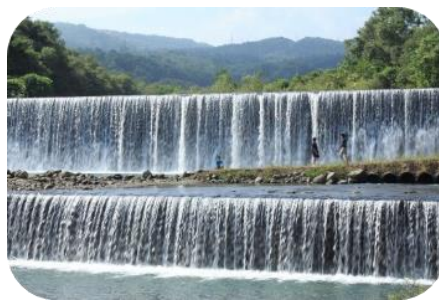
荒川（地蔵原堰堤）
