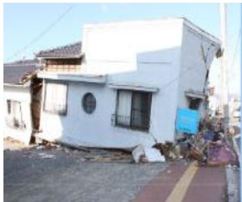
地震により倒壊した建物
