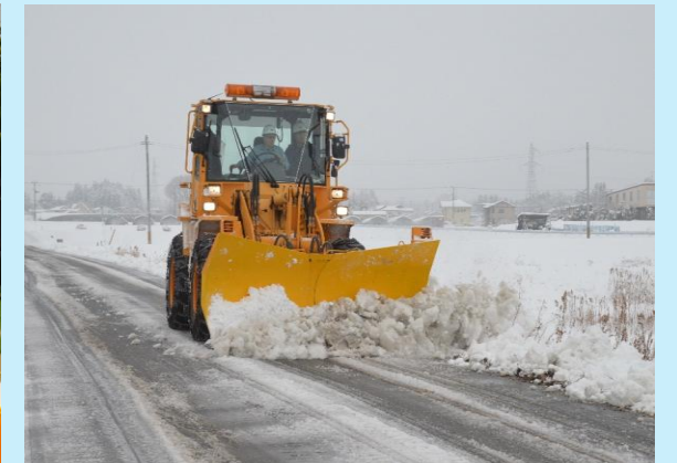
【冬の道路の安全を守る除雪作業】
