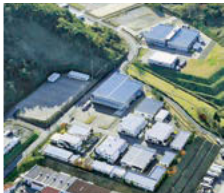
ジーエルサイエンス 福島工場 全景
