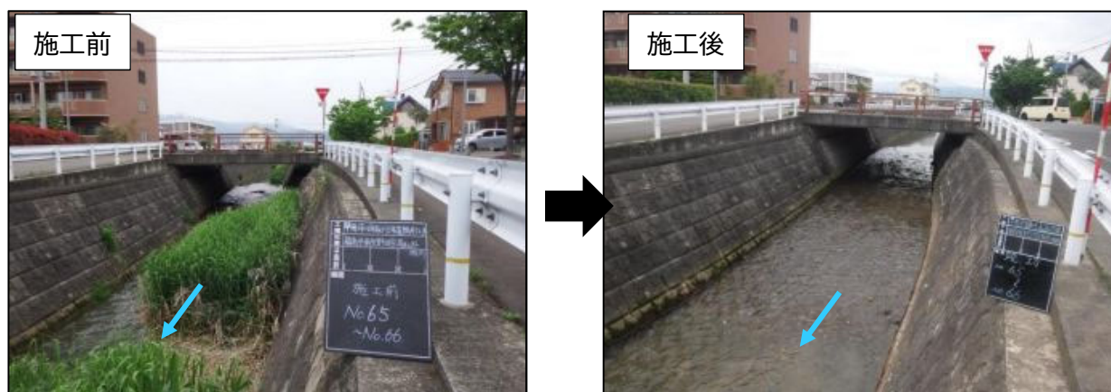
図 6-7 河川浚渫の状況(耳取川)
