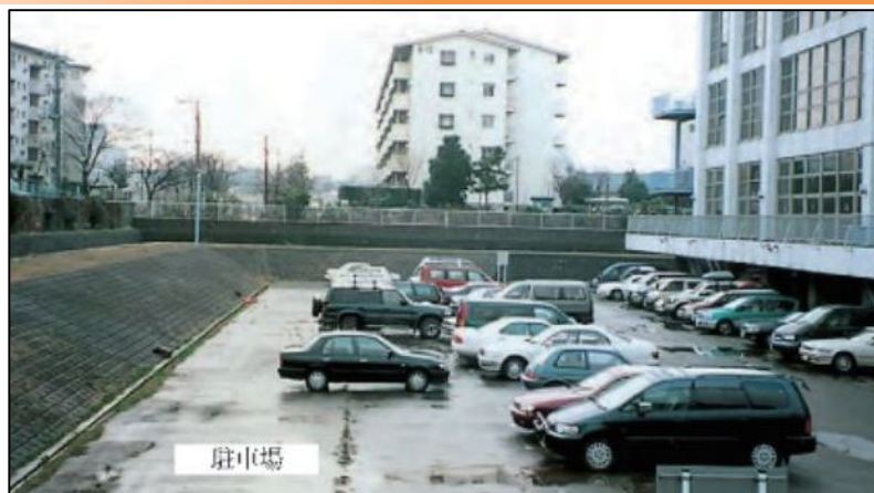
図 6-17 駐車場貯留の事例（埼玉県志木市）
