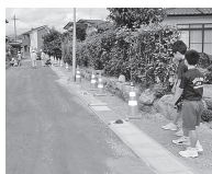
飯坂の道路工事の現場見学
