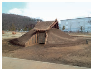
9. 復元した竪穴住居 屋根の木組みの上に土をのせている。
