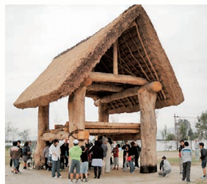
8. 復元した直径90cmの柱の掘立柱建物 1本の柱の重量は3tを超える。縄文時代晩期の頃ギリシャでは第1回古代オリンピック競技会が開催された。
