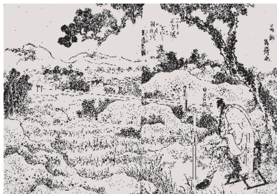
125. 正方儀を以て目的を見通す図(葛飾為斎画)『量地図説』(市蔵)より
