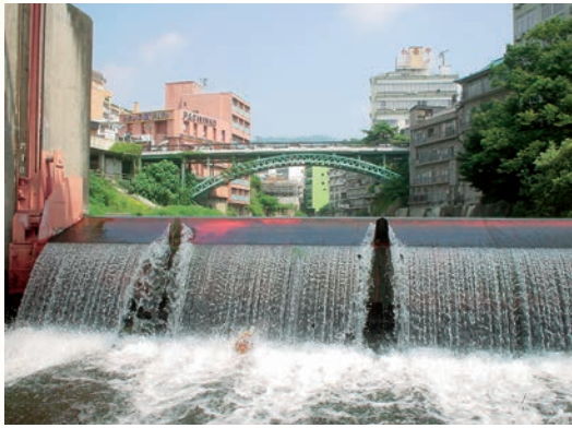
102. 下堰頭首工 とうしゅこう (川から水を取り入れるための施設) (提供：伊達西根堰土地改良区)
