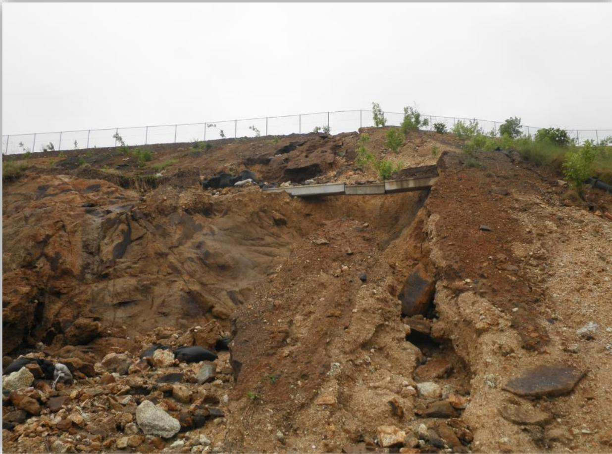
大規模太陽光発電施設の法面崩落による土砂流出
