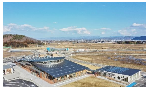
道の駅ふくしまの太陽光発電設備（右建物屋上）
