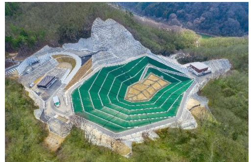
大館山一般廃棄物最終処分場 全景
