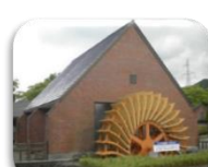
3. 四季の里小水力発電設備
