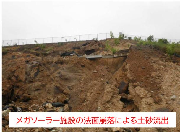
メガソーラー施設の法面崩落による土砂流出
