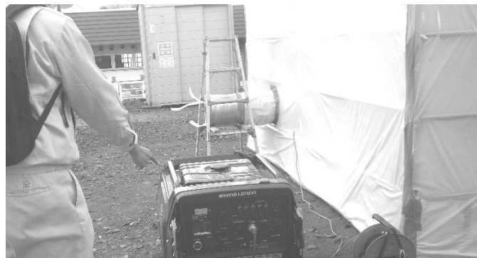
特定粉じん排出作業の養生検査
