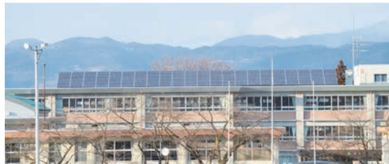
太陽光発電パネル (福島第三中学校)
