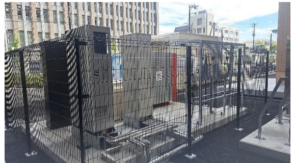
福島市役所複合棟に設置した純水素燃料電池
