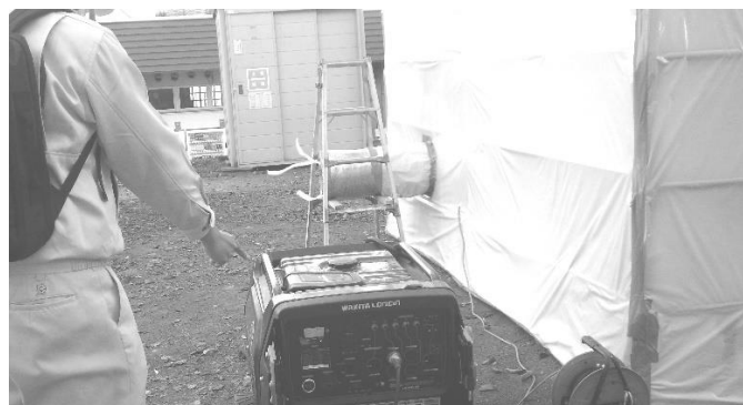
特定粉じん排出作業の養生検査
