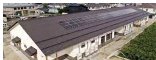
太陽光発電パネル (清水支所)
