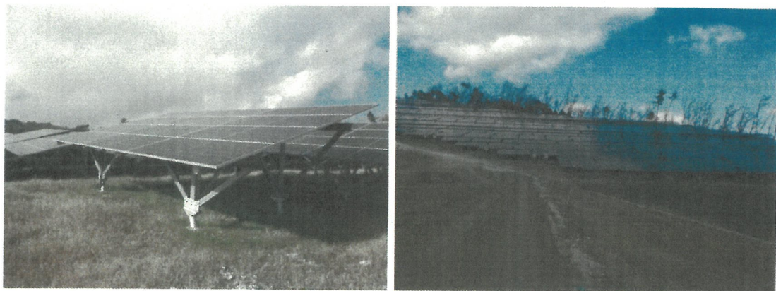
写真1 アレイ群の設置状況
