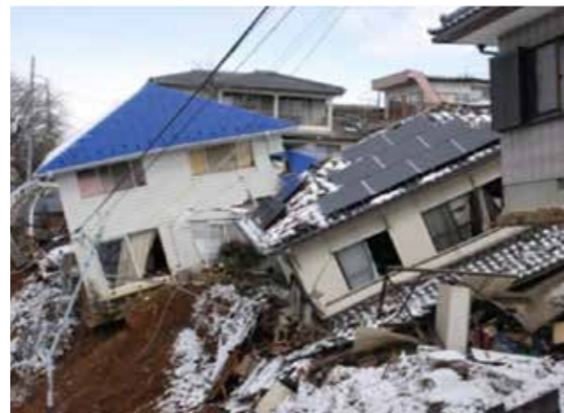
あさひ台団地の法面崩落
