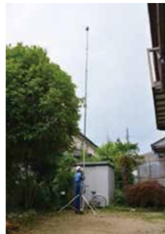
▲高所点検カメラによる状況確認
