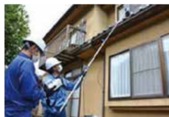
▲高所測定機器によるモニタリング
