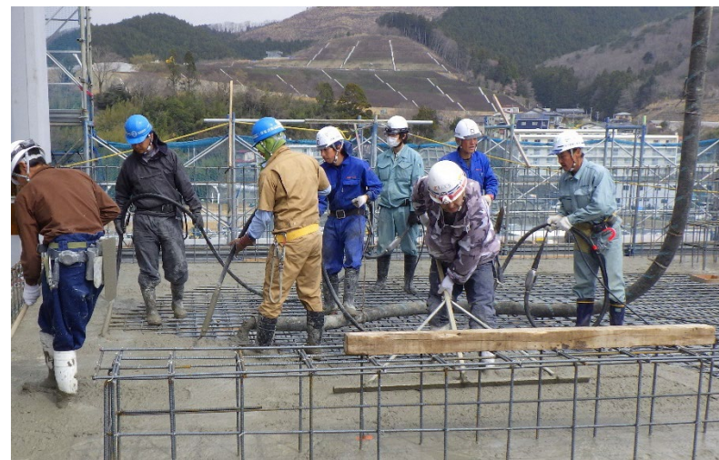
コンクリート工事
