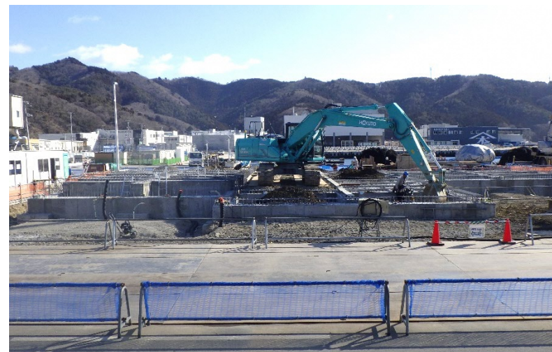
埋め戻し工事
